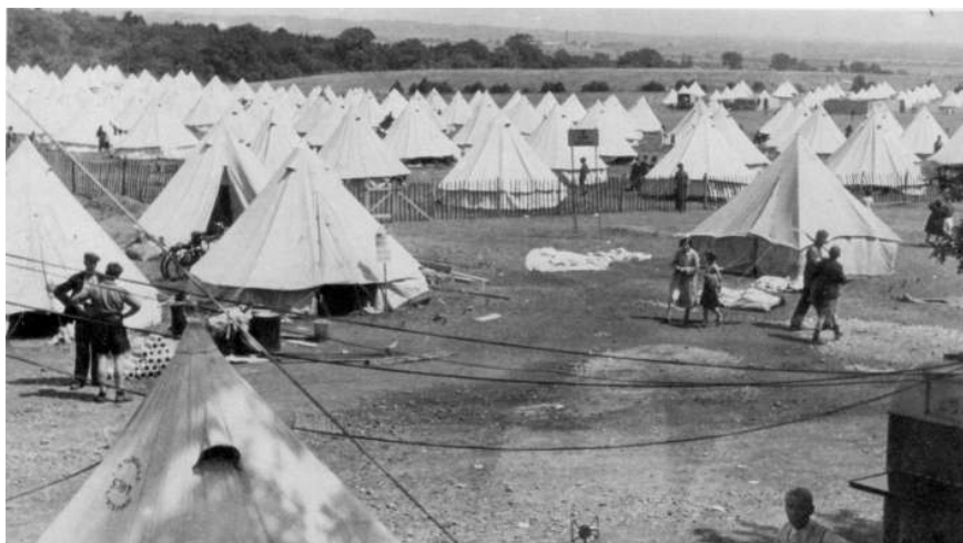
Vista del campamento de Stoneham
